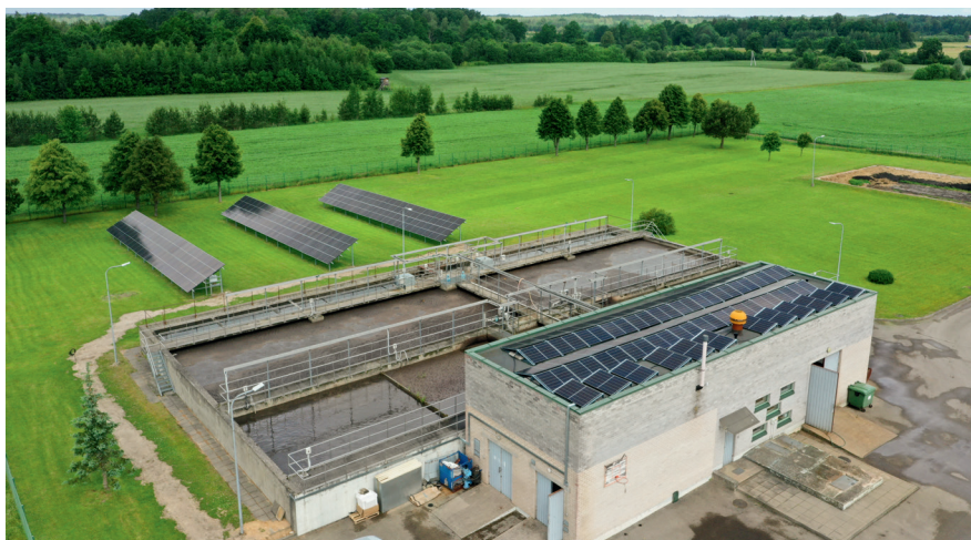
2 pav. Saulės šviesos energijos elektrinės Skuodo nuotekų valykloje
