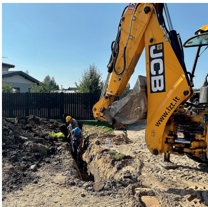
2 pav. Iki esamų namų ūkių sklypų ribų tiesiami vandentiekio įvadai ir nuotekų išvadai, įrengiami vandens apskaitos šulinėliai
