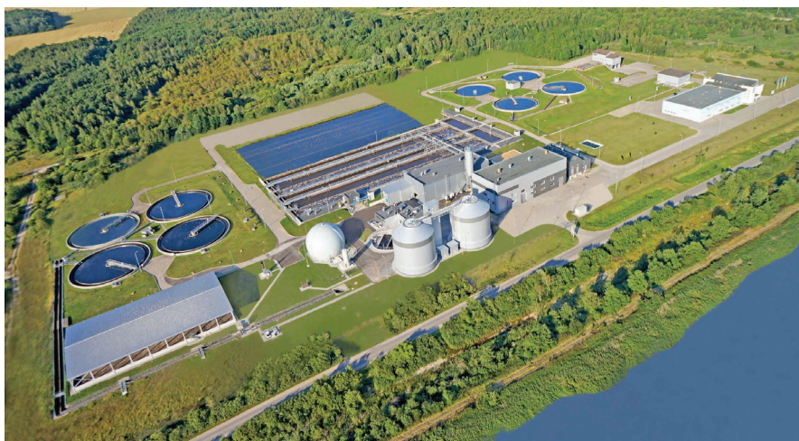
Pav. Šiaulių miesto nuotekų valyklos teritorijoje įrengta saulės elektrinė per metus pagamins apie 450–495 MWh žaliosios elektros energijos
