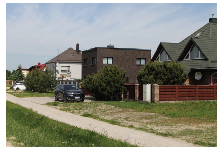
Pav. Vandentvarkos infrastruktūra plėtojama Šiaulių miesto Lieporių–Šventupio individualių namų rajone
