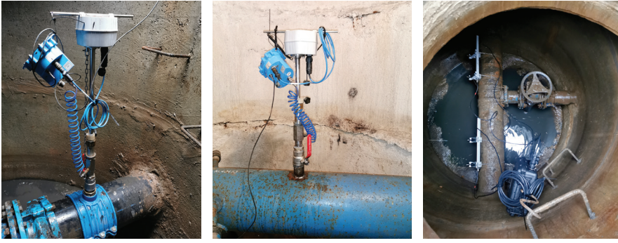
3 pav. Sumontuoti indukciniai invaziniai ir ultragarsiniai debitmačiai
