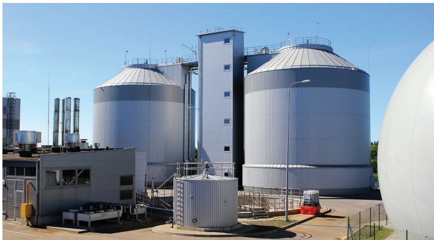
Pav. Šiaulių miesto dumblo apdorojimo įrenginiuose riebalų atliekos pūdomos kartu su nuotekų dumbliu
