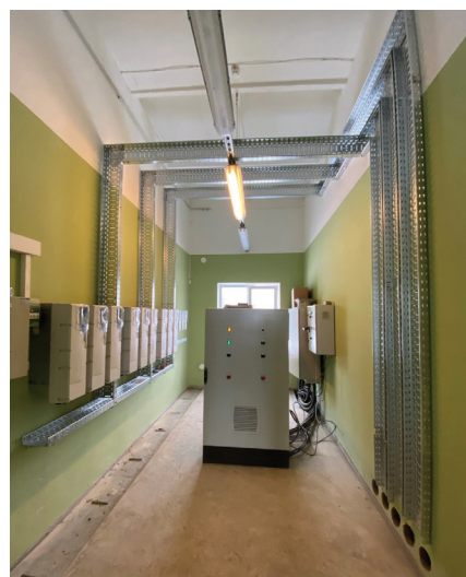
4 pav. Pradėta montuoti automatikos, elektrotechnikos ir technologinė įranga
