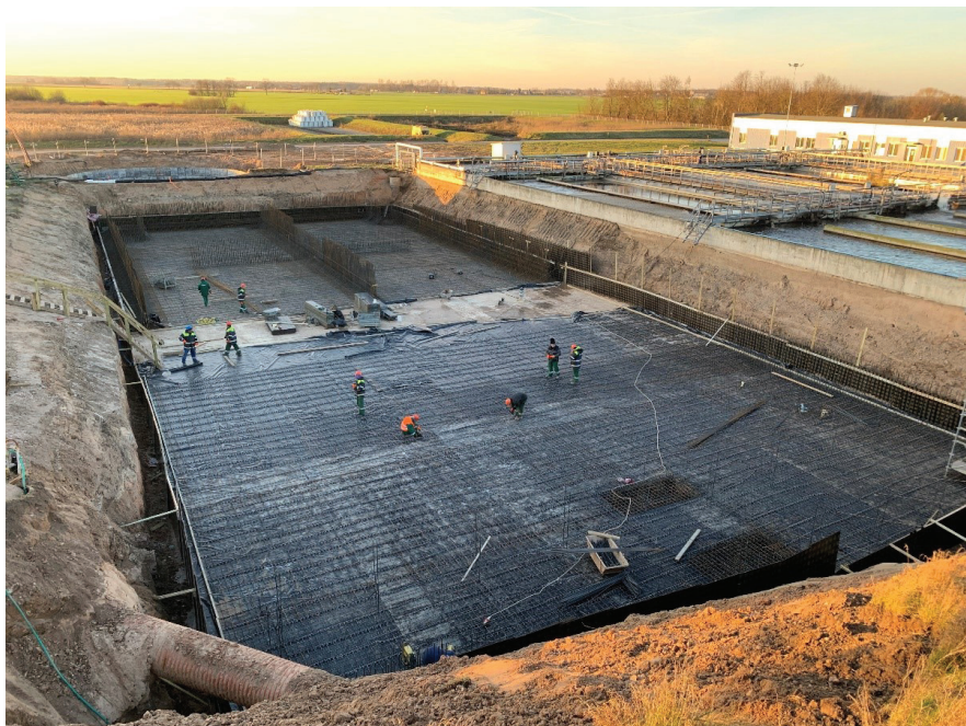
1 pav. Biologinio reaktoriaus dugno plokštės betonavimo darbai
