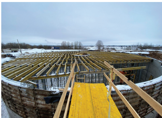
2 pav. Išbetonuotos pramoninių nuotekų talpyklos sienos ir kolona. Vykdomas pasiruošimas įrengti perdangą
