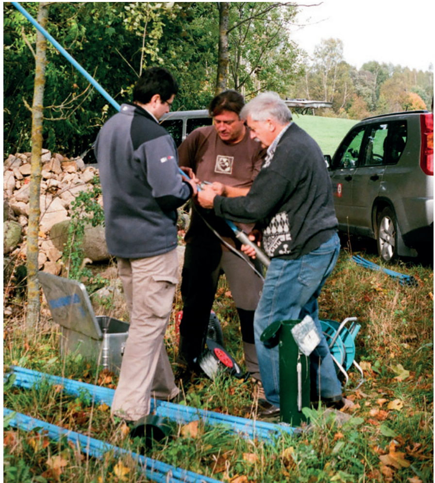
1 pav. Prie monitoringo gręžinio
