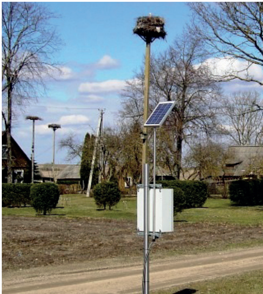
2 pav. Telemetrinė stotis požeminio vandens lygiui stebėti
