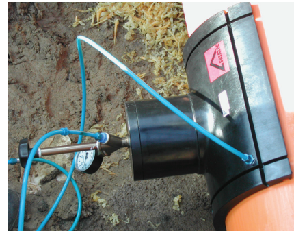
3 pav. Balnas didelio skersmens PE vamzdžiams SA-XL
