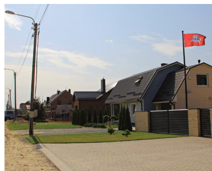
Vandentiekio ir nuotekų tinklai plėtojami Šiaulių miesto Aukštabalio gyvenamųjų namų rajone
