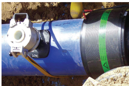
4 pav. Prispaudžiamas balnas didelio skersmens PE vamzdžiams SA-TL
