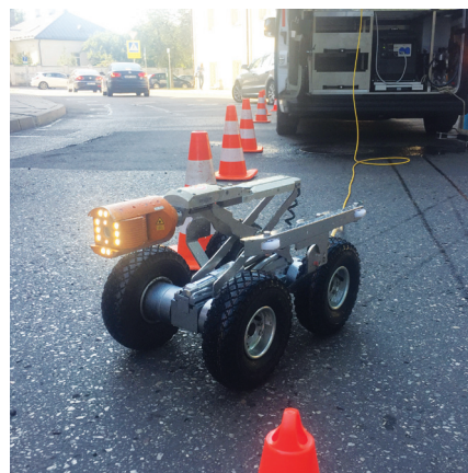
2 pav. Aukšta raiška filmuojantis robotas IBAK pasirengęs leistis į vamzdyną iki 340 m atstumu
