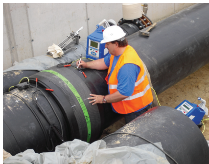
1 pav. „Friatec AG“ specialistų pagalba montuojant didelio skersmens movas
