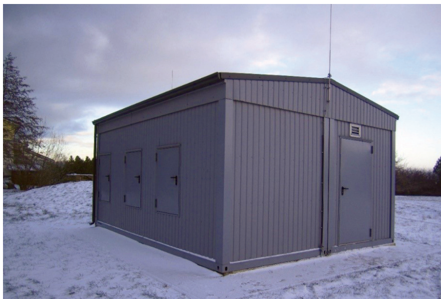
3 pav. Karklės vandens ruošyklos pastatas
