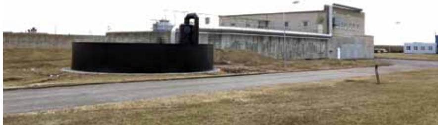
2 pav. Mažose valymo įrenginiuose kvapų gaudyklė nėra aktuali, tačiau didesniuose miestuose, kur taikomas pirminis nuotekų valymas, toks orą valantis biofiltras, sumontuotas „Klaipėdos vandens“ nuotekų valykloje, yra labai reikalingas
