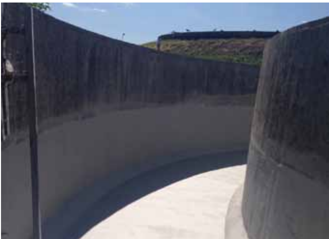
3 pav. Latakų betoniniai paviršiai padengti gruntu (kairėje) ir chemiškai atsparia apsaugine danga (dešinėje)
