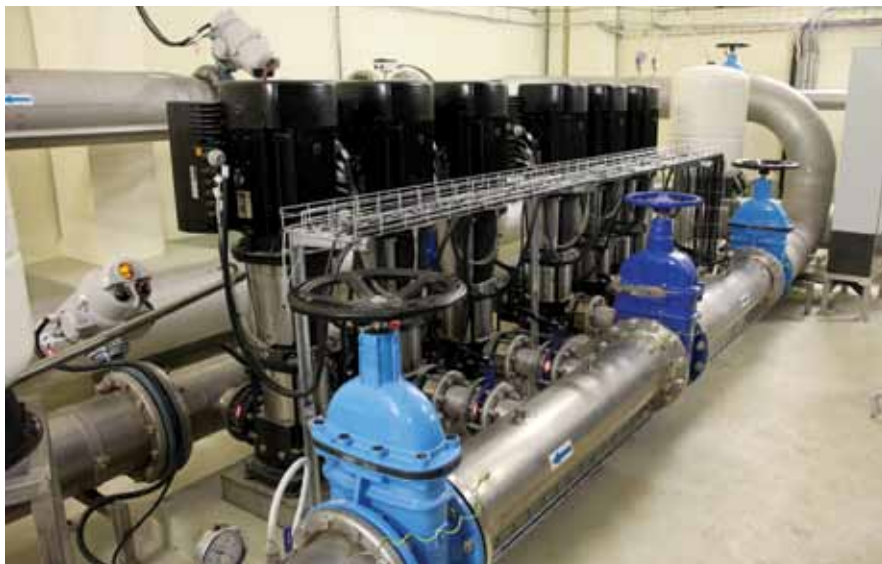
4 pav. Antrojo vandens pakėlimo siurblynė paruoštą geriamąjį vandenį pumpuoja į miesto tinklus
