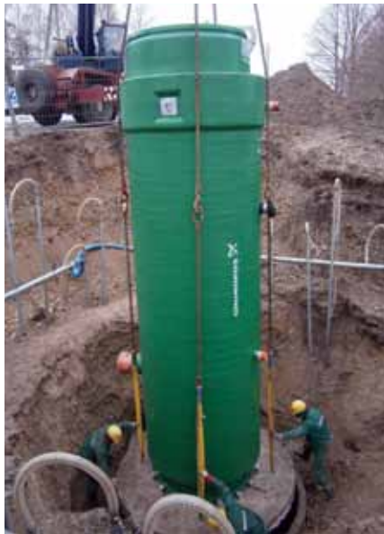
2 pav. Nuotekų perpumpavimo siurblynės statyba Pelkių g., Šiauliai
