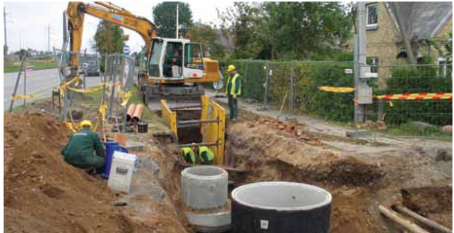
1 pav. Naujų vandentiekio ir nuotekų tinklų statyba Serbentų g., Šiauliai
