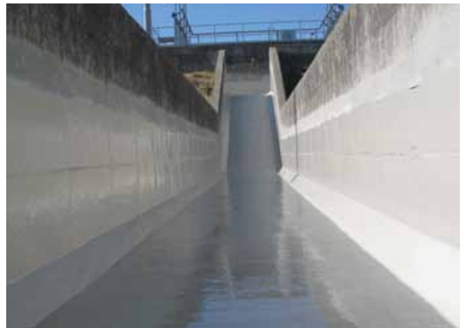
3 pav. Latakų betoniniai paviršiai padengti gruntu (kairėje) ir chemiškai atsparia apsaugine danga (dešinėje)
