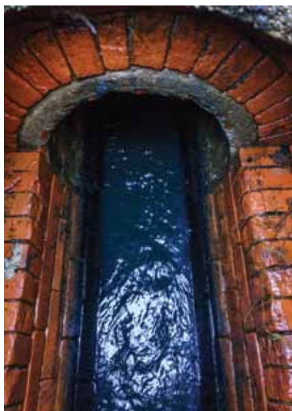
2 pav. 1937 m. įrengto pirmojo Panevėžio miesto centralizuoto nuotekų rinktuvo fragmentas (šandieninis vaizdas)
