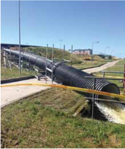
2 pav. Laikiniai sumontuotas vamzdis, kuriuo nuotekos nukreipiamos iš antrinio nusodintuvo į išvalytų nuotekų kanalą pabaigą
