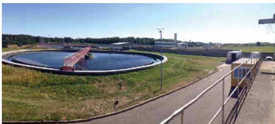
1 pav. AB „Klaipėdos vanduo“ nuotekų valykloje rementuojami antriniai nusodintuvai
