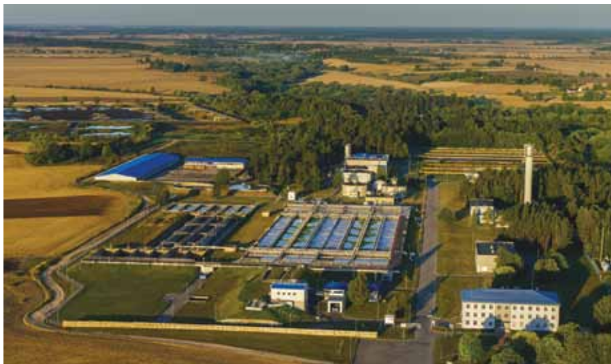
3 pav. Panevėžio miesto nuotekų valyklos vaizdas iš paukščio skrydžio
