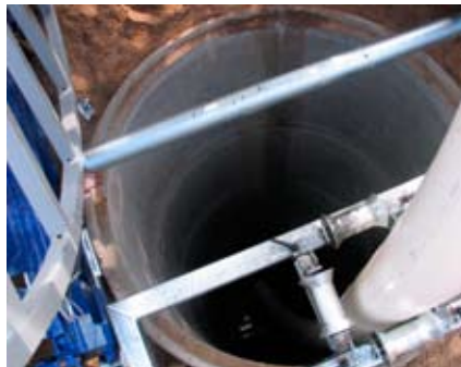
2 pav. „Compact Pipe“ vamzdžio įtraukimas į seną renovuojamą vamzdį
