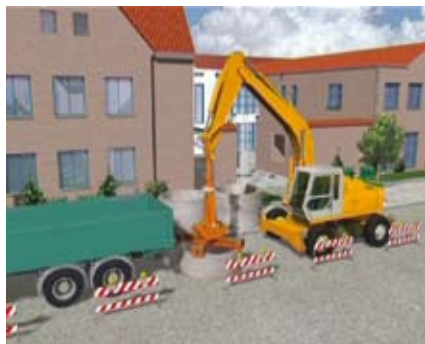
4 pav. Šulinio, iš kurio vykdomi mikrotunelio darbai, įrengimas
