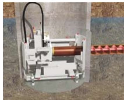
8.1 pav. Išplatinus kanalą įrengiamas vamzdis
