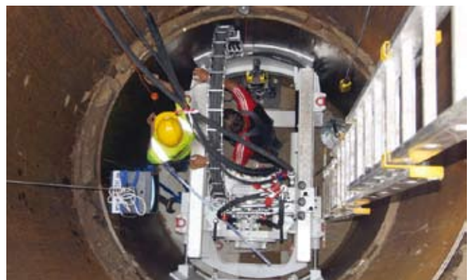
2 pav. Vamzdžio klojimas naudojant mikrotunelingu
