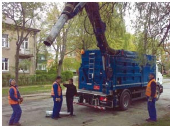
1 pav. Vakuuminis ekskavatorius
