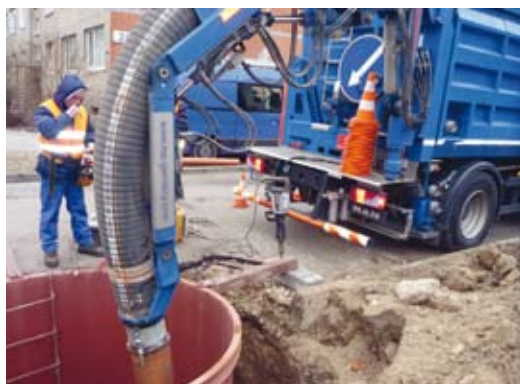
2 pav. Vakuuminio ekskavatoriaus panaudojimas 4 m gylyje remontuojant buitinių nuotekų tinklus
