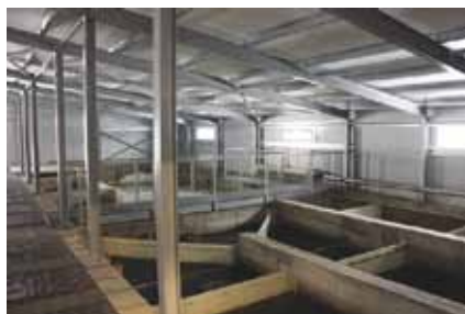
3 pav. Viešbučio Meridien-Vilon 600 m³ per parą valyklos vidaus vaizdas
