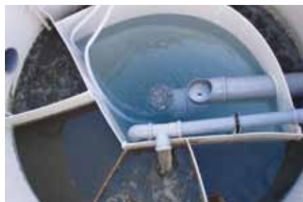
2 pav. Valymo įrenginių iki 50 GE vaizdas
