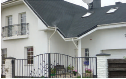
3 pav. Į gatvės buitinių nuotekų tinklus paleisti dūmai veržiasi pro namo lietvamzdžius
