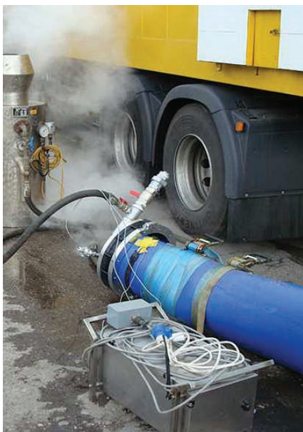
1 pav. Garo turbina gamina vamzdžio šildymui sočiuosius garus, o vamzdžio priėmimo gale garas ir susikondensavęs vanduo saugiai išleidžiami per kondensato rinktuvą
