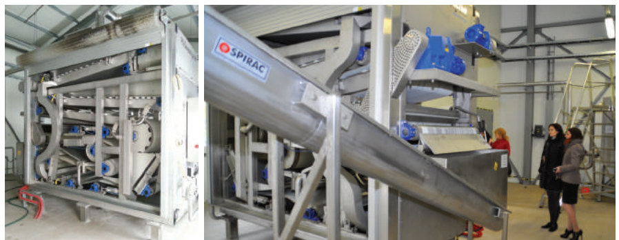
5 pav. Dumblo apdoravimo įrenginiai
