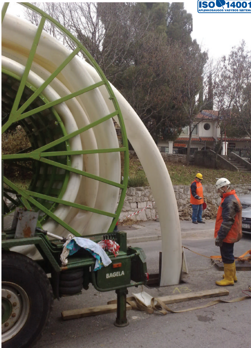
5 pav. Tiesiogiai nuo stovinio ant priekabos būgno vamzdis traukiamas į šulinį. Priekabą būgnui taip pat rekomenduojama panaudoti montavimo aikštelėje išvyniojamam vamzdžiui valdyti
