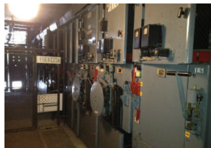
3 pav. 10 kV skirstomieji įrenginiai prieš rekonstrukciją
