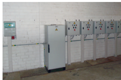
4 pav. Naujai įrengti automatikos ir gręžinių valdymo skydai
