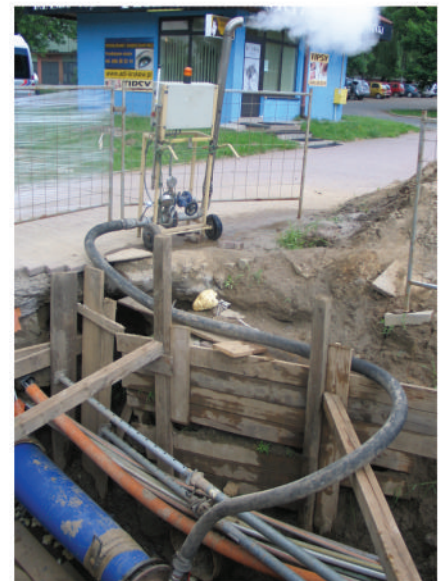
3 pav. Linijos gale sumontuotas kondensato rinktuvas ir duomenų siustavas
