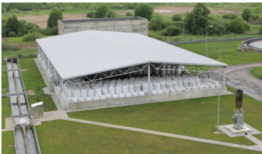
3 pav. Išdžiovintas dumblas (iki 10 proc. drėgmės) pakuojamas į maišus ir sandėliuojamas specialiai įrengtoje aikštelėje
