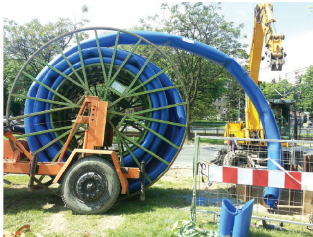
2 pav. Automobilineje priekaboje – būgnas su 100 metrų DN500 PE100 SDR26 PN6,0 vamzdžio
