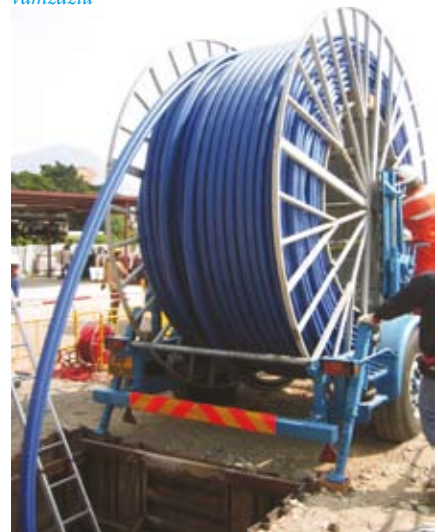
5 pav. Vandentiekio tinklų atnaujinimas Compact Pipe vamzdžiu
