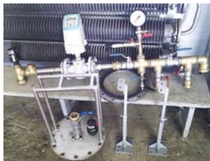
1 pav. Tipinis apskaitos mazgas su kolonos sandarinimo flanšu ir tvirtinimo elementais
