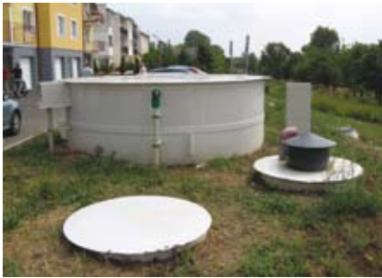
3 pav. 30 m 3 /d našumo biologiniai nuotekų valymo įrenginiai šalia gyv. namų
