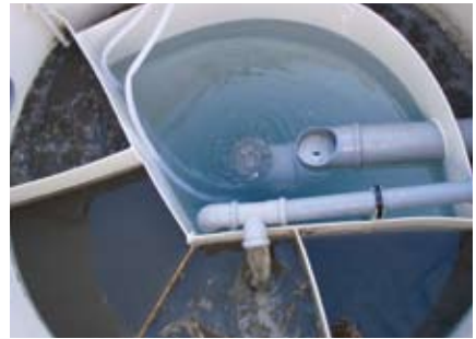
5 pav. „August ir Ko“ veikiančios nuotekų valyklos vidaus vaizdas
