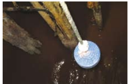
1 pav. POLIFLOCK-BPP biopreparatų pakuotės ir jų dozavimas nuotekų siurblinėje
