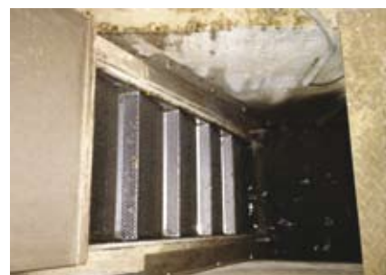
4 pav. Nuotekų priėmimo siurblinė ir grotos prieš POLIFLOCK-BPP naudojimą ir po jo
