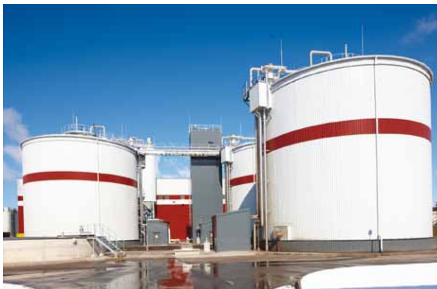
2 pav. Technologija: nuotekų dumblas bus pūdomas sandariuose dumblo pūdytuvuose
