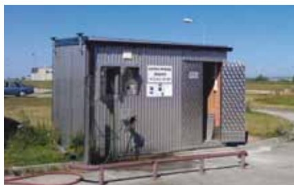
1 pav. Nuotekų priėmimo stotelė nuotekų valykloje
