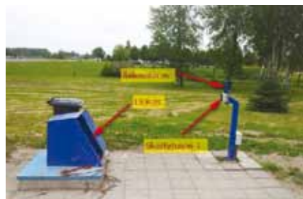
2 pav. Nuotekų priėmimo įrenginys Gargžduose
