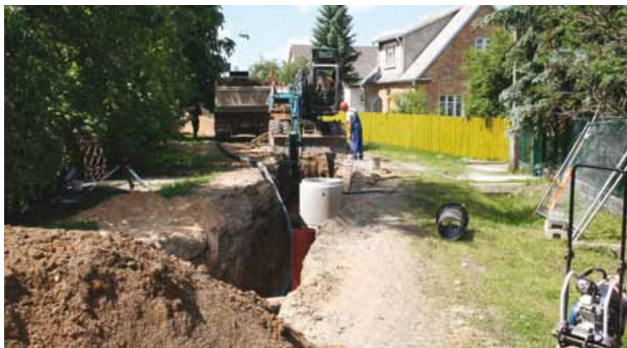
1 pav. Vandentiekio ir nuotekų tinklų statybos darbai Šiaulių miesto Tilžės, Verdulių, Kanapių, Girulių gatvių kvartale
