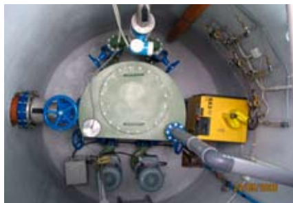
4 pav. Nuotekų talpykla ir „sausai“ montuojami siurbliai siurblinėje (Objektas: Insbud Rybnik, Lenkija)
