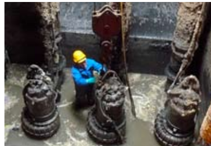
9 pav. „Šlapiai“ sumontuotų siurbių techninis aptarnavimas eksploatacavimo vietoje (šaltinis: „Scottish Water“)
