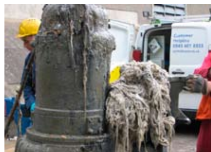
10 pav. Įprastinės užkemšiančios medžiagos, pašalintos iš siurblio (šaltinis: „Scottish Water“)
