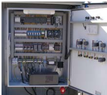
2 pav. NS automatinio valdymo skydas. Vidaus įrangos išdėstymas ir montžas, lauko variantas
