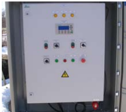
1 pav. NS automatinio valdymo skydas. Vaizdas iš priekio, lauko variantas
