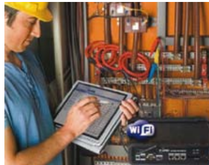
2 pav. Elektros energijos analizė su firmos ELSPEC (Izraelis) įrenginiu BLACKBOX Portable
