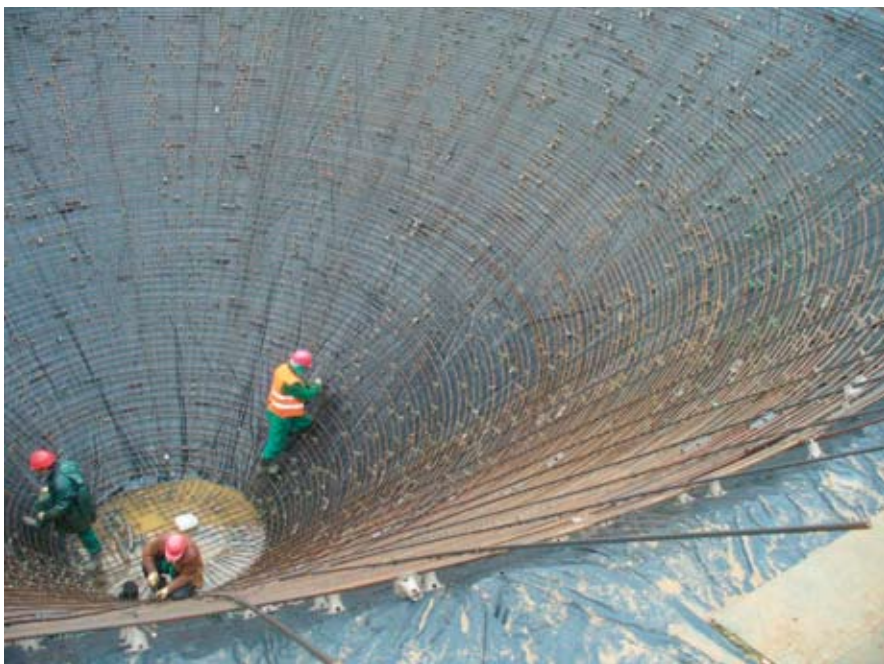
3 pav. Dumblo apdorojimo įrenginių statybos darbai
