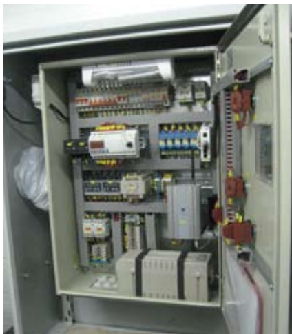
4-5 pav. Unifikuota NPS valdymo įranga
