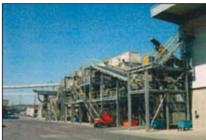
3 pav. Juostinė dumblo džiovykla
