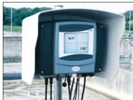
3 pav. SC 1000 valdiklis, prie kurio jungiama iki 8 elektrodų su sensoriniu ekranu
