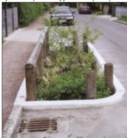
2 pav. Vienos iš geriausio tvarkymo procedūrų, aprašytų pritaikomoje sprendimų priėmimo paramos sistemoje, iliustracija: įtaisas, mažinantis automobilių greitį gyvenamosiose vietovėse, laikinas lietaus nuotekų kaupimo ir infiltracijos baseinas, augalai kaip puošybos elementas (Hoppogarten, Berlyno priemiestis; projektuotojas IPS, DayWater mokslinis partneris)
