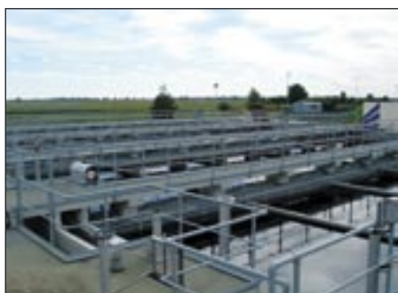
4-6 pav. Dažyti Kee Klamp turėklai Panevėžio nuotekų valymo įrenginiuose
