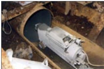
1 pav. Vandentiekio vamzdinių renovacija padengiant cemento skiediniu
