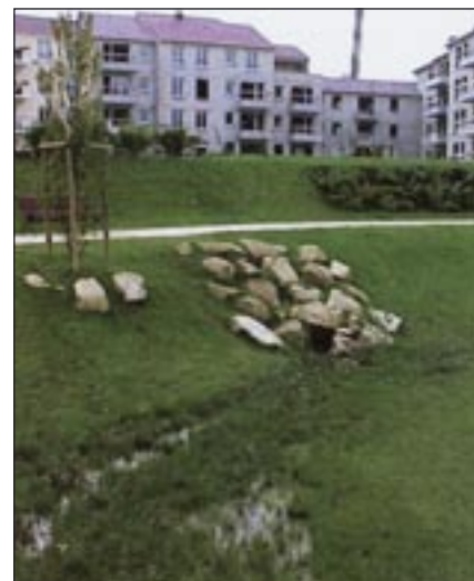
5 pav. Infiltracijos griovys
