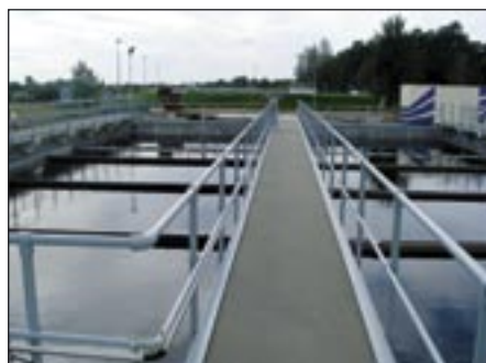
4-6 pav. Dažyti Kee Klamp turėklai Panevėžio nuotekų valymo įrenginiuose
