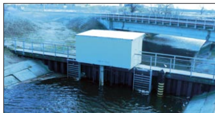
3 pav. Klaipėdos kanalo vandens pralaida į Kuršių marias prie Medžių įlankos
