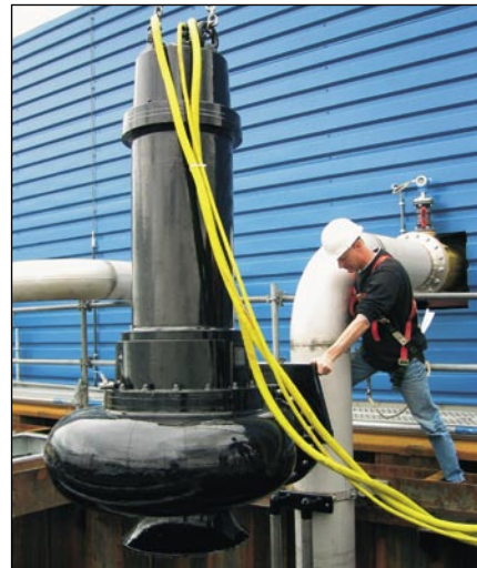
Pav. Nuotekoms šalinti ir vandenvos ūkyje naudojami „Wilo EMU“ siurbLIAI. „Wilo EMU“ „Ceram“ danga, apsaugodama siurblių detales nuo korozijos ir abrazyvo, sumažina dėvėjimąsi ir prailgina siurblio eksploatavimą.
