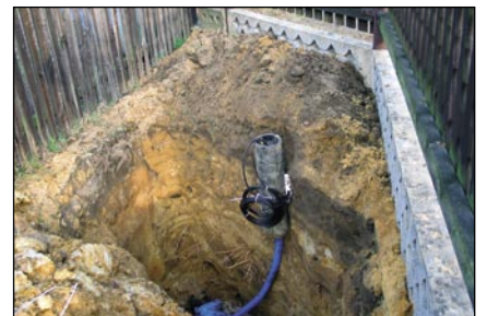
3 pav. Srauto jutiklio kabeliai pratinami paviršiumi, duobę ruošiamasi užkasti
