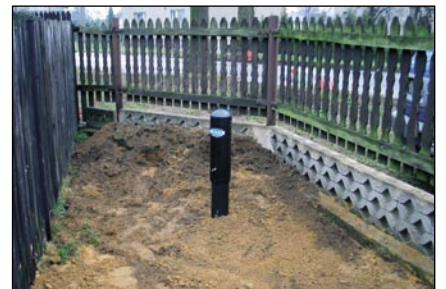
5 pav. Taip atrodo sumontuotas vandens skaitiklis SITRANS F M MAG8000 su GSM modemu
