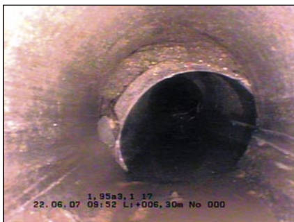
13 pav. Dėl pasikeitusių vamzdžių sandūrų sumažėjęs skerspjuvis
