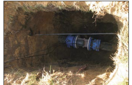
2 pav. Elektromagnetinis srauto jutiklis, sumontuotas į plastikinį vamzdį
