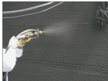
2 pav. Mineralinė betono paviršiaus apsaugos danga užnešama šlapio purškimo metodu
