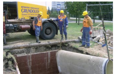
2 pav. Vamzdynų renovacija
