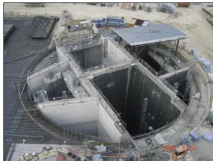
5 pav. 2004 m. statyti nuotekų valymo įrenginiai Singapore Changi. Betonas apsaugotas naudojant polimerinį silikatą Konusit KK 10
