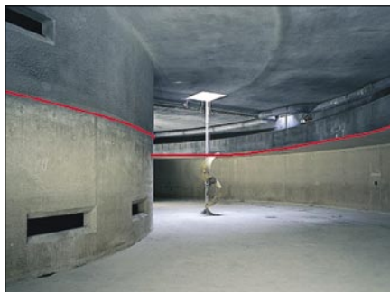
4 pav. Betono paviršiaus apsauga su Konusit KK 10 dujų atakos zonoje
