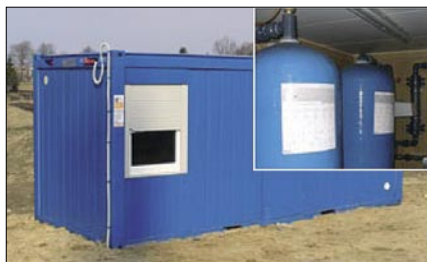
1 pav. Vandens paruošimo įranga konteineryje
