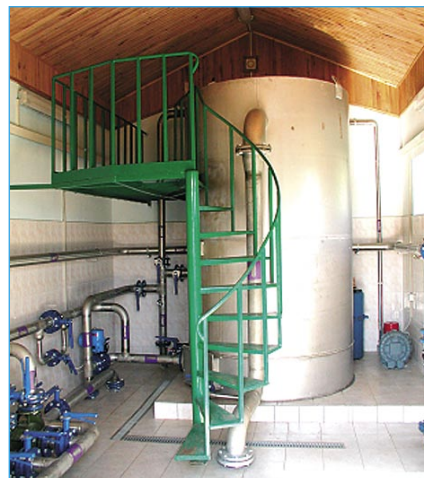
3, 4 pav. Modernizuota Tytuvėnų vandens ruošykla
