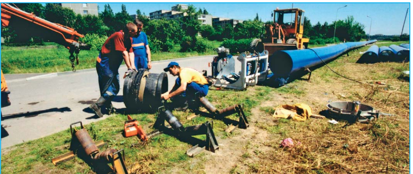
ISPA projekto įgyvendinimas: vandentiekio tinklų rekonstrukcija, įvelkant PE vamzdį
