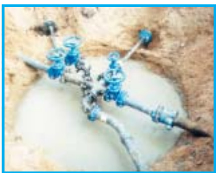
Rekonstruota sklendžių kamera
