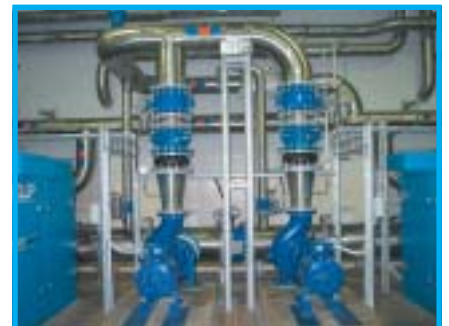
AISI 304 rūšies plieno vamzdžiai idealiai tin-ka geriamojo vandens vamzdynams
