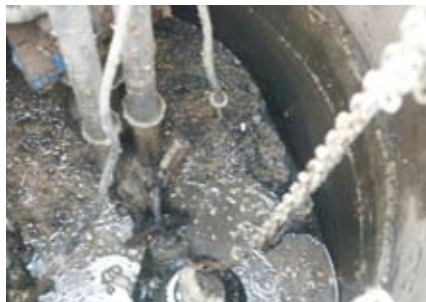
3 pav. „Šlapiai“ montuojami panardinami siurbliai (Šaltinis: dipl. inž. J. Mäding, Vokietija)
