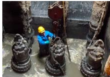
9 pav. „Šlapiai“ sumontuotų siurblių techninio aptarnavimo eksploatavimo vietoje (šaltinis: „Scottish Water“)
