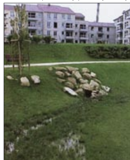
5 pav. Infiltracijos griovys
