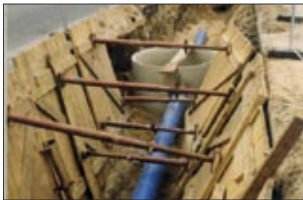
2 pav. Vandentiekio vamzdinių renovacija įvelkant PE vamzdį
