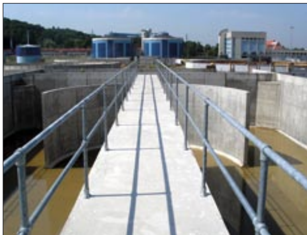
2-3 pav. Cinkuoti Kee Klamp turėklai ant gelžbetoninių tiltelių Kauno nuotekų valymo įrenginiuose
