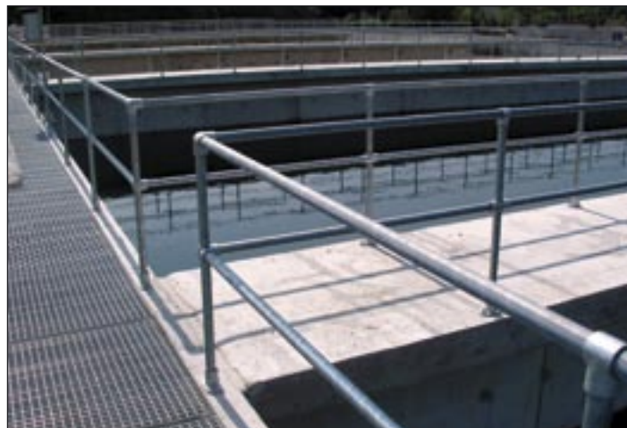
2-3 pav. Cinkuoti Kee Klamp turėklai ant gelžbetoninių tiltelių Kauno nuotekų valymo įrenginiuose
