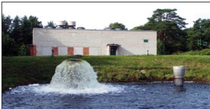
5 pav. Vandenį iš Klaipėdos kanalo pakeliantį siurblyną su aeratoriumi
