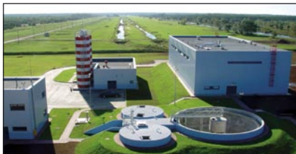
1 pav. Klaipėdos miesto III vandenvietės vandens ruošykla. Fone: dešinėje – Klaipėdos kanalas, centre – infiltraciniai kanalai
