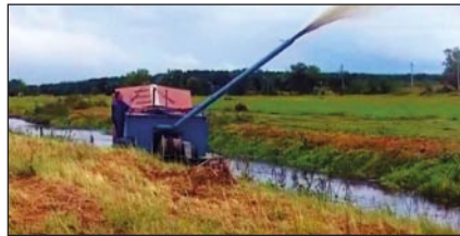
7 pav. Žemsiurbė valomi infiltraciniai kanalai
